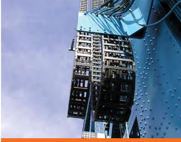
TL Kunststoff-Energieführungskette mit eloxierten Aluminiumstegen für höhere Festigkeit bei Starkwindbedingungen an einer Hubbrücke.
